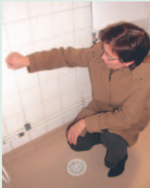
Sirpa Laaksonen suorittaa huoneistotarkastusta. Hän koputtelee kylpyhuoneen kaakeleita saadakseen selville, että laatat ovat kunnolla kiinni. Samalla hän tarkistaa saumojen kunnan.
